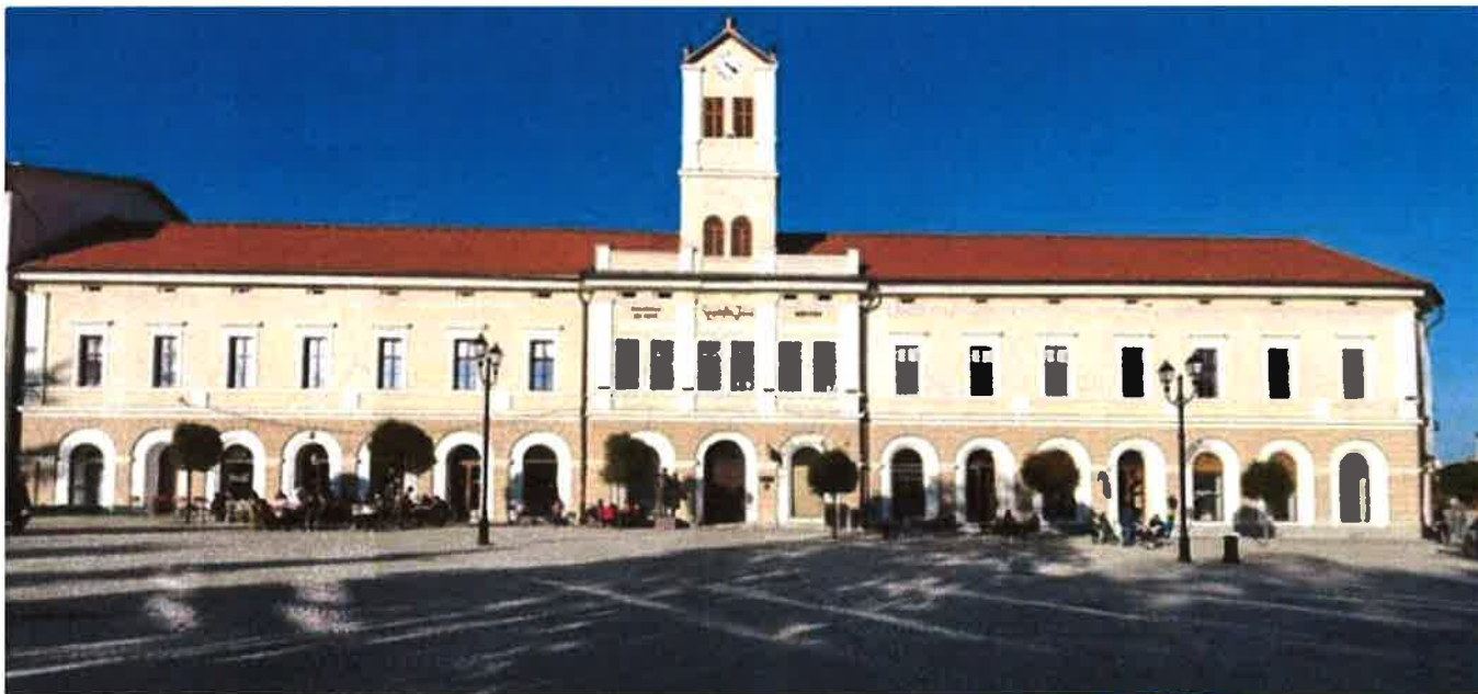
Vedere fațadă principală a clădirii
